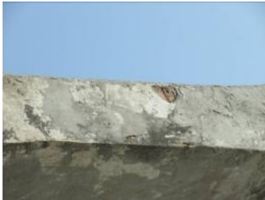
7.3.10 北侧拱肋侧面露筋照
