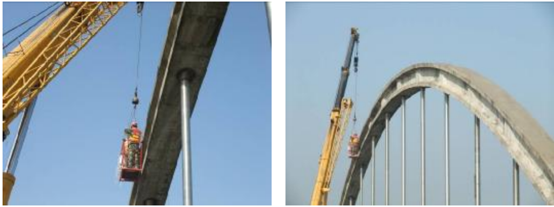
图 9.6.1 工作人员现场布置应力和位移测点
