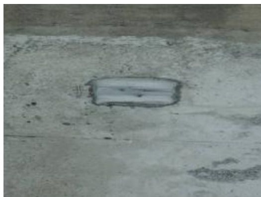
图 7.4.9 开凿后封锚照
