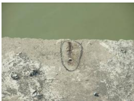
图 7.2.1 系梁露筋照 1
