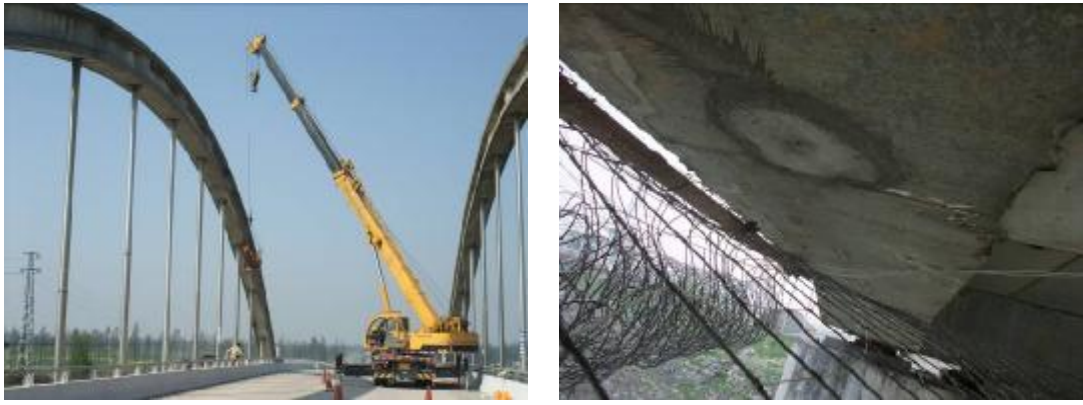
图 8.1 现场检测工具
