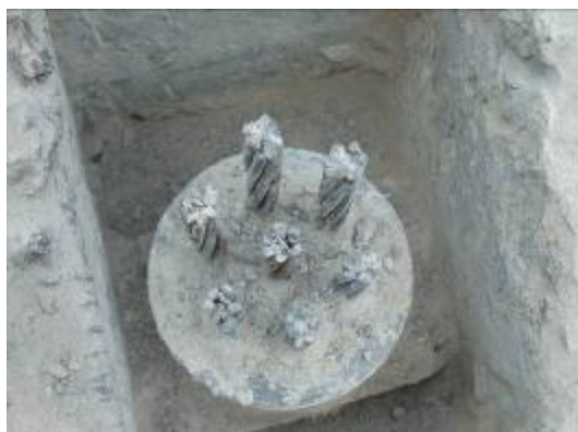
图 7.4.8 西南侧 2#吊杆上锚头检测照
