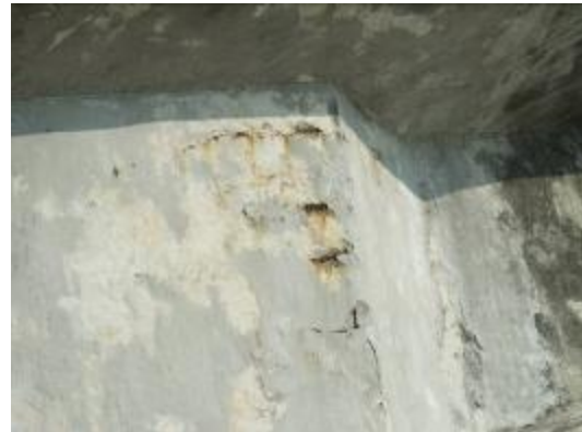
7.3.10 北侧拱肋侧面露筋照
