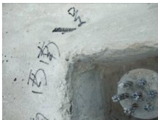
7.4.7 西南侧 1#吊杆上锚头检测照
