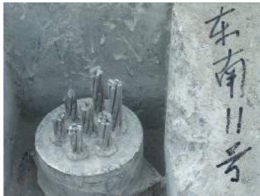
7.4.5 东南侧 11#吊杆上锚头检测照
