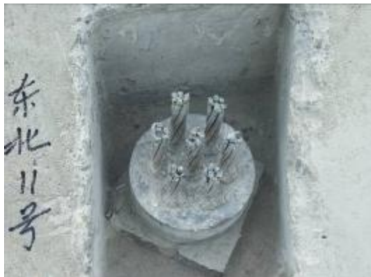
图 7.4.4 东北侧 11#吊杆上锚头检测照
