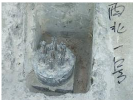
图 7.4.6 西北侧 1#吊杆上锚头检测照
